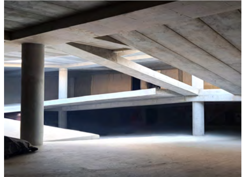
ESTACIONAMIENTO CONDOMINIO COUNTRY
