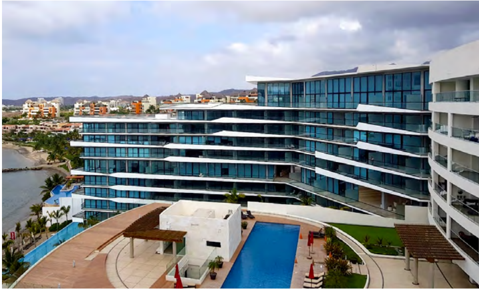
PENÍNSULA NARVAL ESTRUCTURA DE CONCRETO. 2 EDIFICIOS. 2 SÓTANOS: 6,703.00 M 2 . 7 NIVELES POR TORRE: 11,523.00 M 2 . ALTURA: 22.00 M. UBICACIÓN: BUCERÍAS, NAYARIT. PROPIETARIO: CITICAPITAL.
