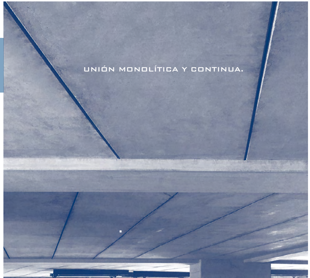
DETALLE UNIÓN PRETRABE - PRE LOSA
